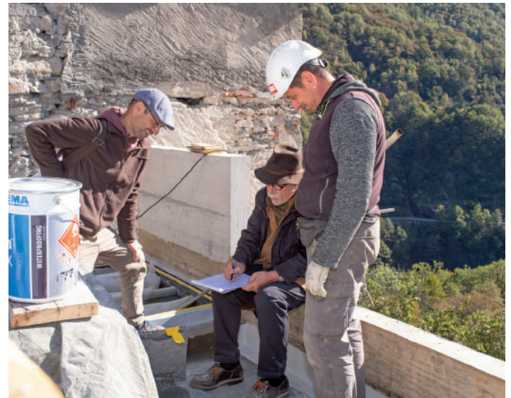
L'architecte Edy Quaglia (au milieu) explique certains détails d'exécution aux ouvriers (Corippo, TI).
